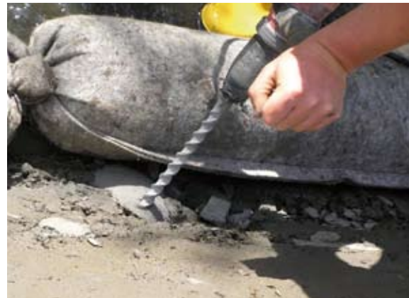
Vorbohren zum Setzen der Stahlnägel
