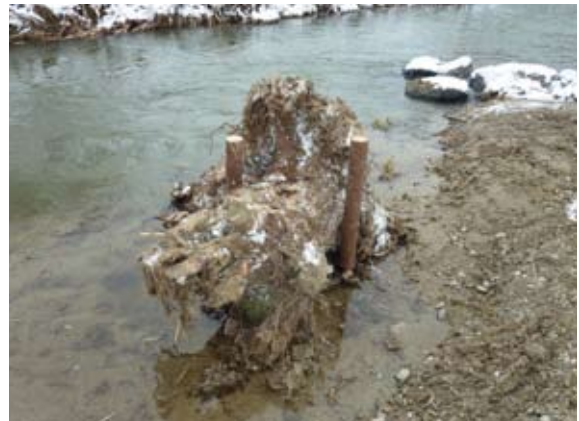
Mit Pfählen befestigter Wurzelstock (2010)
