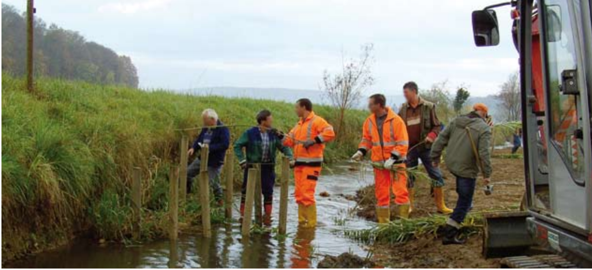
Umflechten der Pfähle mit Weidenruten
