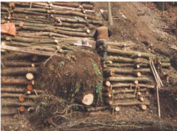
Einbindung eines gefällten Baumes
