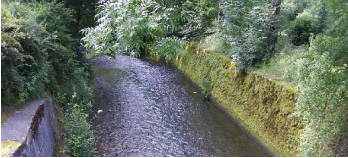
Bestand vor der Umgestaltungsmaßnahme: Naturferne Ufermauern und Sohlschwellen (Juni 2009)
