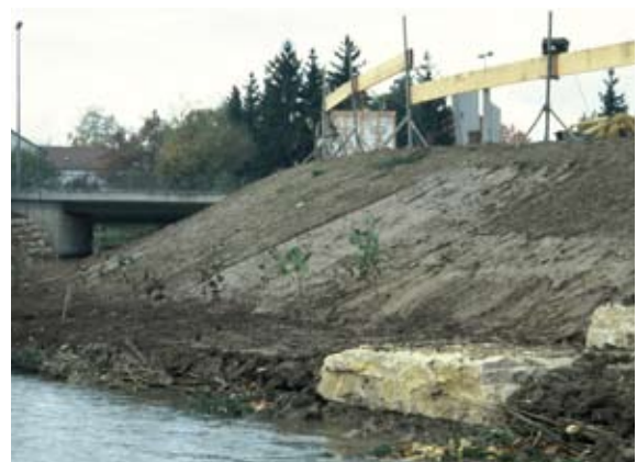
Austrieb im ersten Jahr nach Einbau
