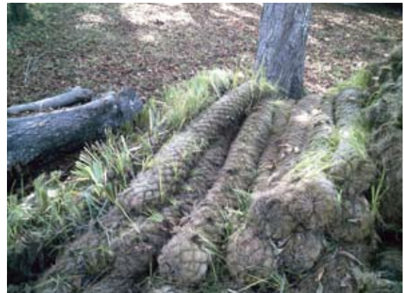
Vegetationswalzen vor dem Einbau
