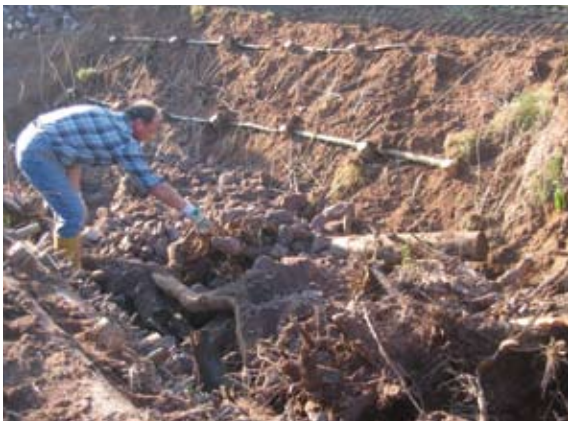
Sohlstabilisierung mit Wurzelstöcken
