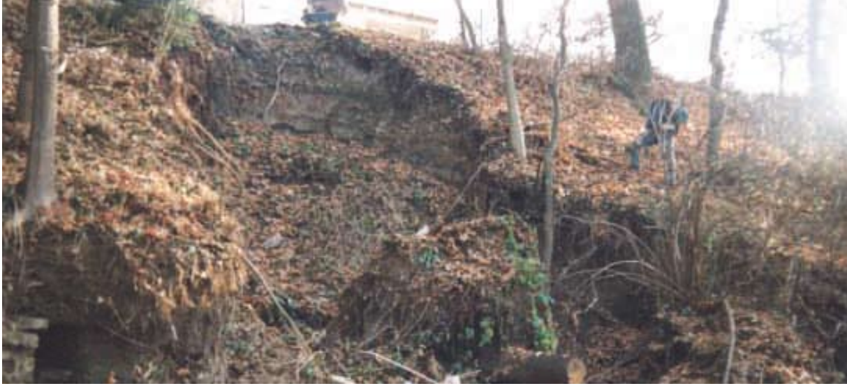
Uferabbruch an der Echaz (1997)
