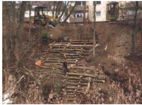
Wiederherstellung des Ufers mittels Krainerwand
