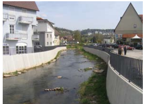
Pfahlbuhnen mit dahinterliegenden Totholzfaschinen und Vegetationswalzen (2006) (III)
