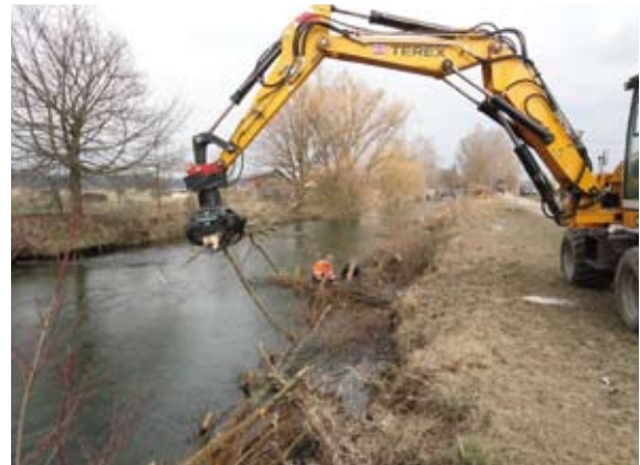
Bauphase 1, Einbau der Buhnen
