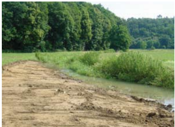
Erdarbeiten bei der Lonerenaturierung (2010)
