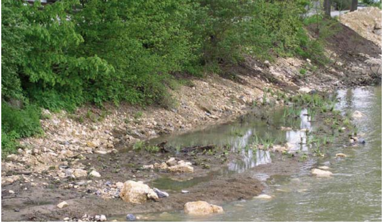
Eingebaute Vegetationswalzen unmittelbar nach Fertigstellung (2004)
