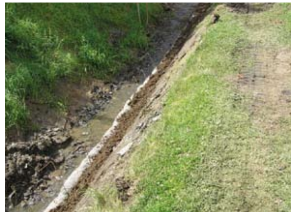
Übererdung und Modellierung des Ufers
