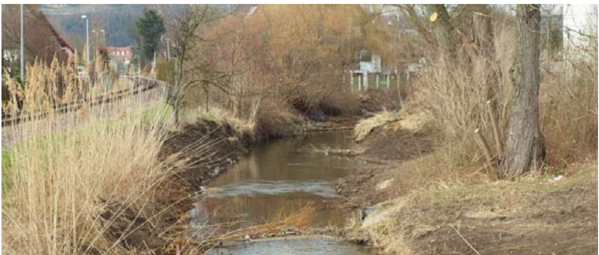
Nach Fertigstellung, Blick bachabwärts (II)
