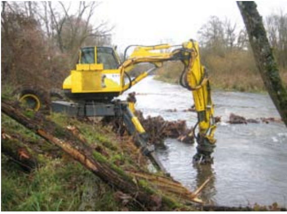
Einbau der Wurzelstöcke mittels Schreitbagger mit Bohraufsatz (2006)
