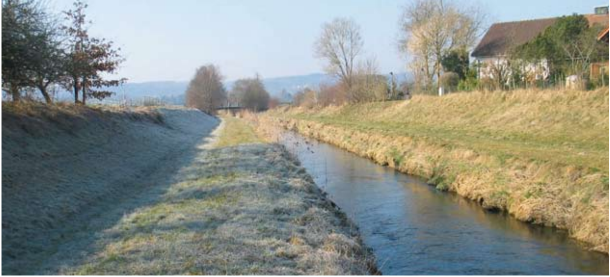
Seefelder Aach vor der Baumaßnahme (2009)
