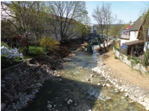
Böschungssicherung durch Kokosmatten
