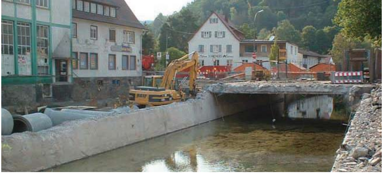
Abbruch der Betonplatte über der verdolten Waldach (2004)
