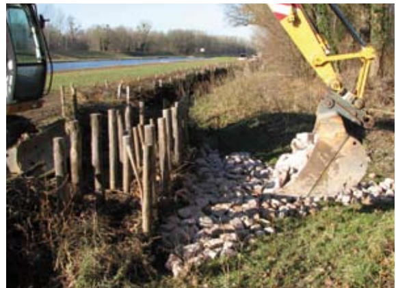
Einbau Wasserbausteine 10-20 kg als Kolksschutz
