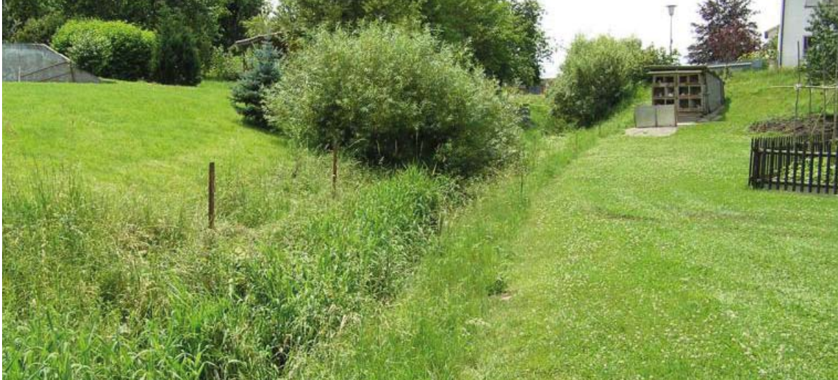
Leimgrubenbach vor der Umgestaltung (2012)
