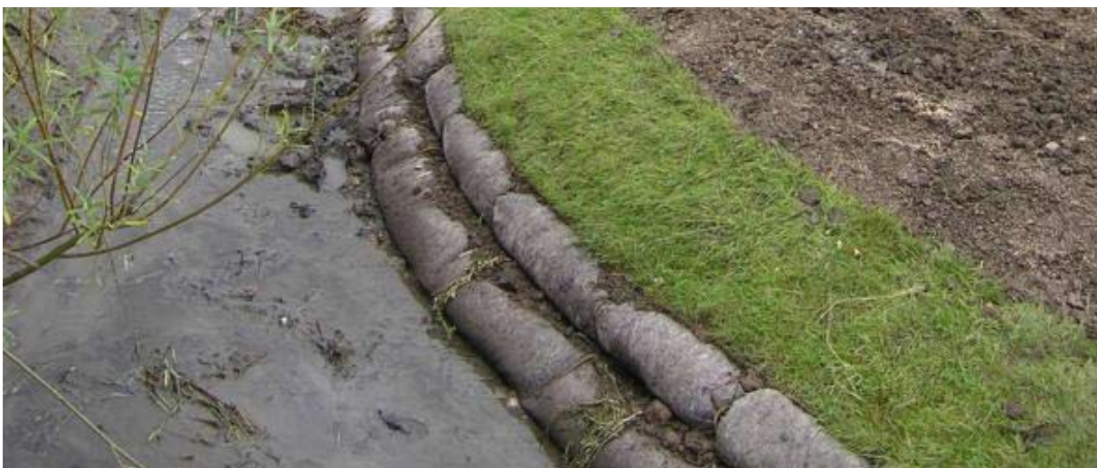
Fertig eingebaute Vegetationswalze (2012)
