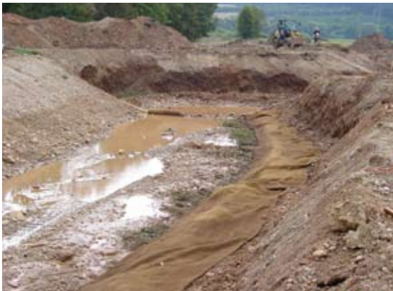
Die unterste Geotextilfascine wird gefüllt und umgeschlagen
