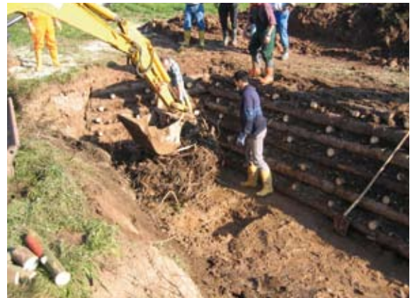
Einbau der Wurzelstöcke
