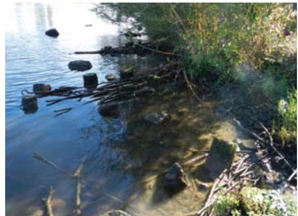
Entwickelte Lahnungen mit Treibgut an der Körschmündung in den Neckar nach 4 Jahren
