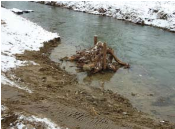
Ufermodellierung und Einbau der Wurzelstöcke (2010)
