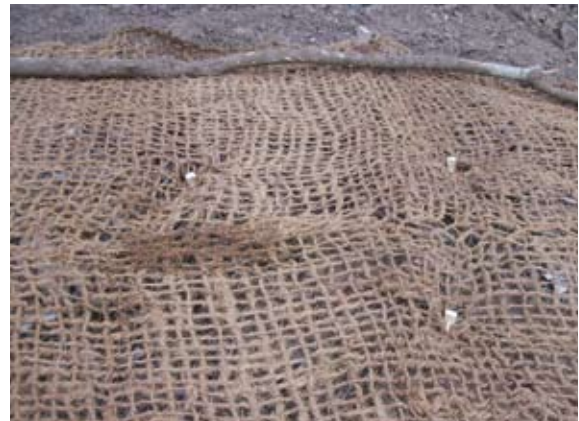
mit Böschungsnägeln aus Holz befestigte Erosionsschutzmatten (Oktober 2010)
