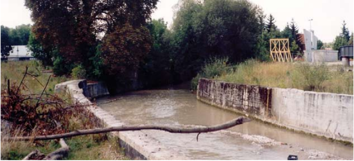
Echaz nach Abbruch der Gebäude (1998)
