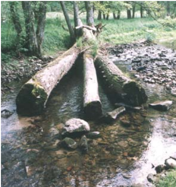
Die gleiche Buhne 2005 durch Verdriftung aufgefüchert und unter-spült: Entstehung einer Schnelle oberhalb mit Substratdiversifizie-rung unterhalb (Gebler 2005)
