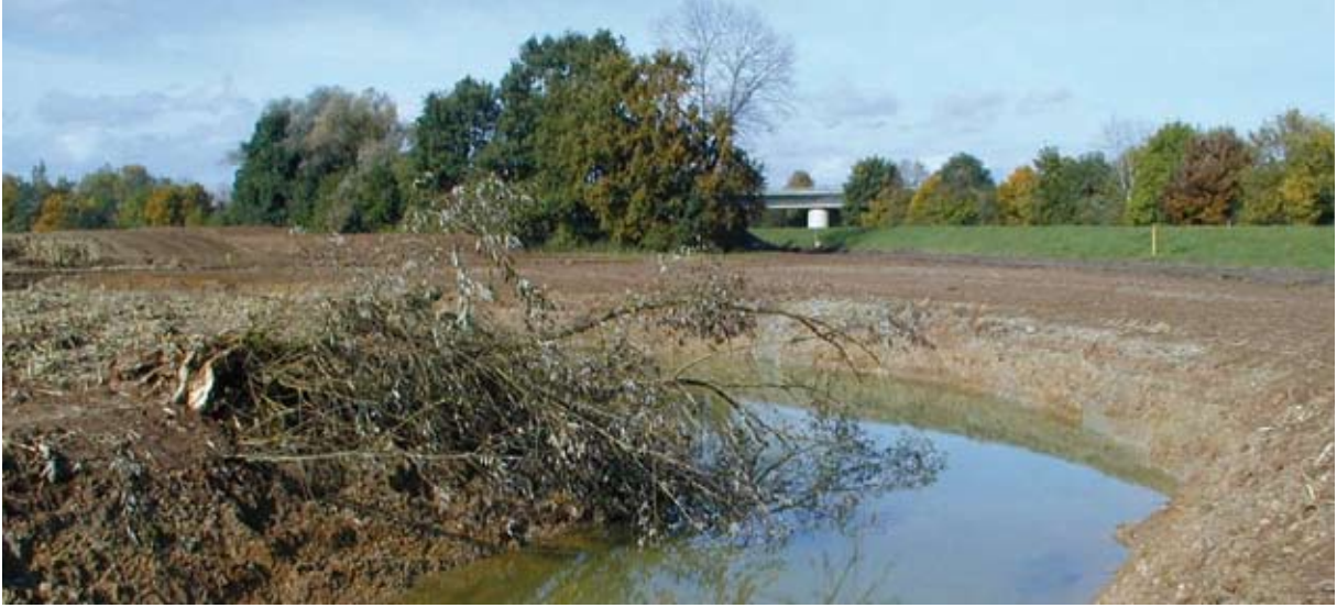
Neuer Schutterverlauf unmittelbar nach der Umbaumaßnahme
