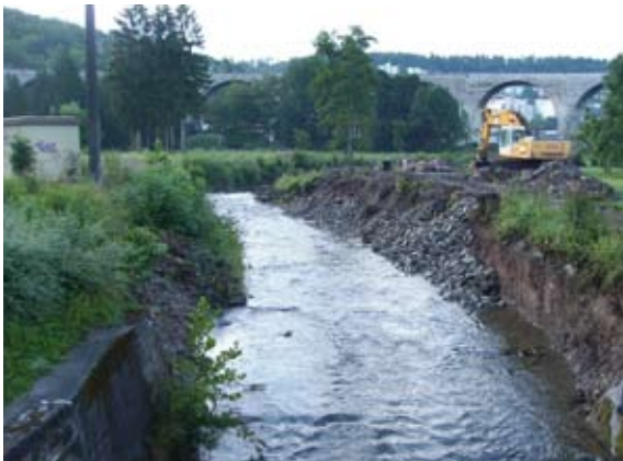
Abbruch Ufermauern (August 2010)
