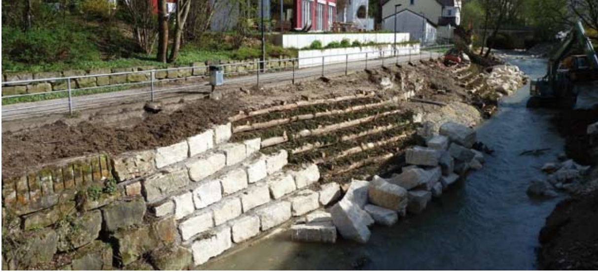
Fertiggestellte Krainerwand und Blocksteinmauer
