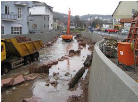
Einbau von Pfahlbuhnen (2004) (I)
