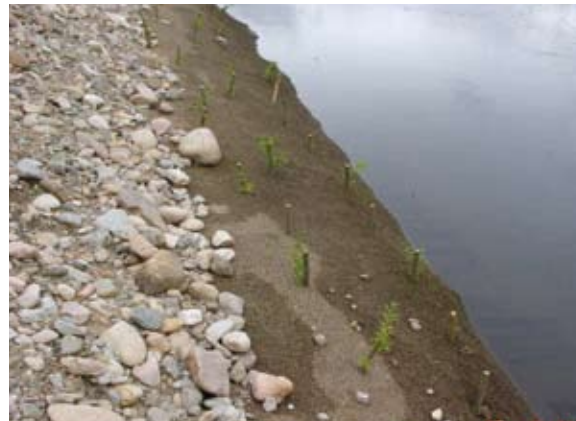
Eingebaute Geotextilfascine mit Weidenstecklingen (2013)
