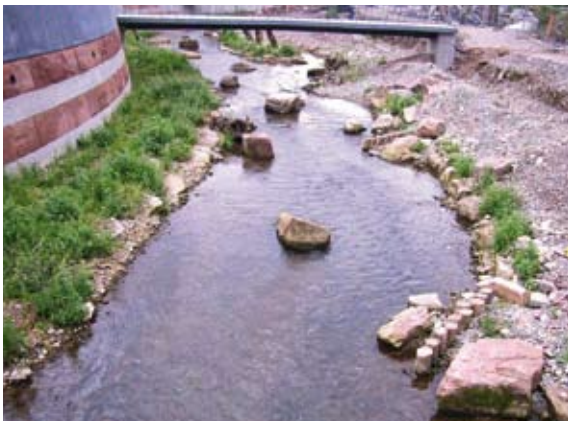
Naturnah gestaltetes Niedrigwasserbett mit Senkfaschinen und Pfahlbuhnen (2005)
