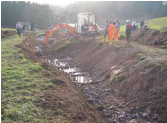
Sohlaufhöhung und Aufweitung mit unterschiedlichen Bauweisen
