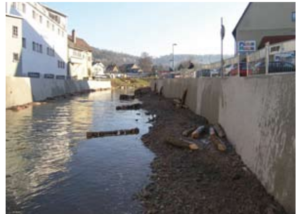
Fertiggestellte Pfahlbuhnen zur Strömungslenkung (2005) (II)
