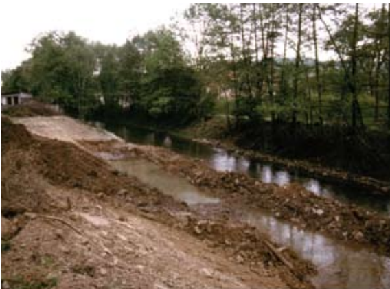
Erdarbeiten zur Gewässeraufweitung
