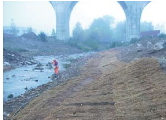
Einbau Erosionsschutzmatten (Oktober 2010)
