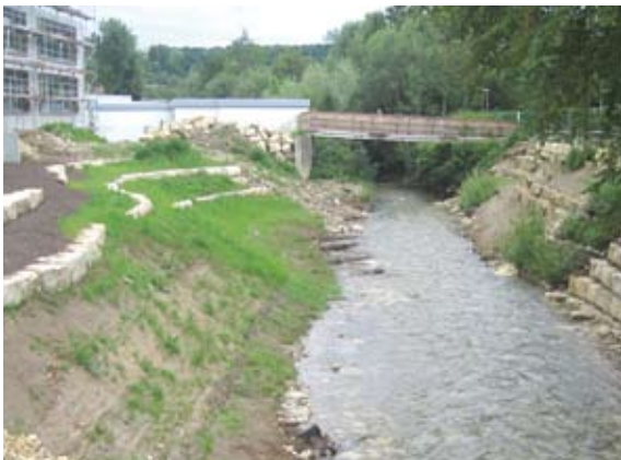
Baustelle nach Beendigung der Bauarbeiten
