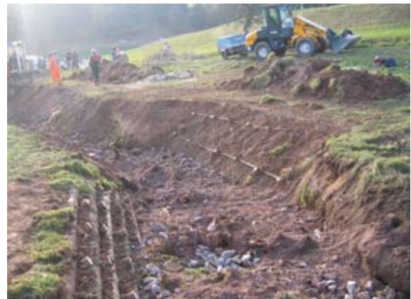
Überschüttete Wurzelstöcke (im Vordergrund)
