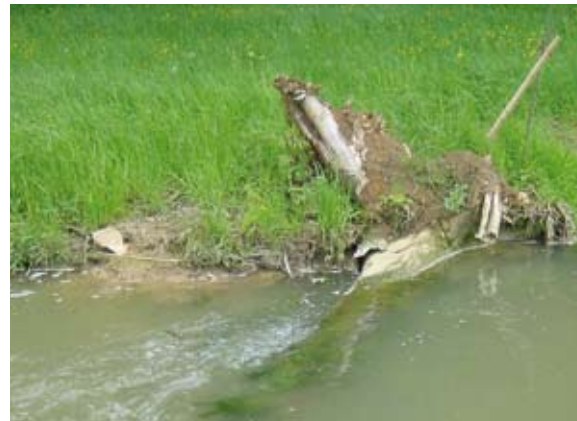
Baumstamm mit Wurzelstock als Leitbuhne (2003)
