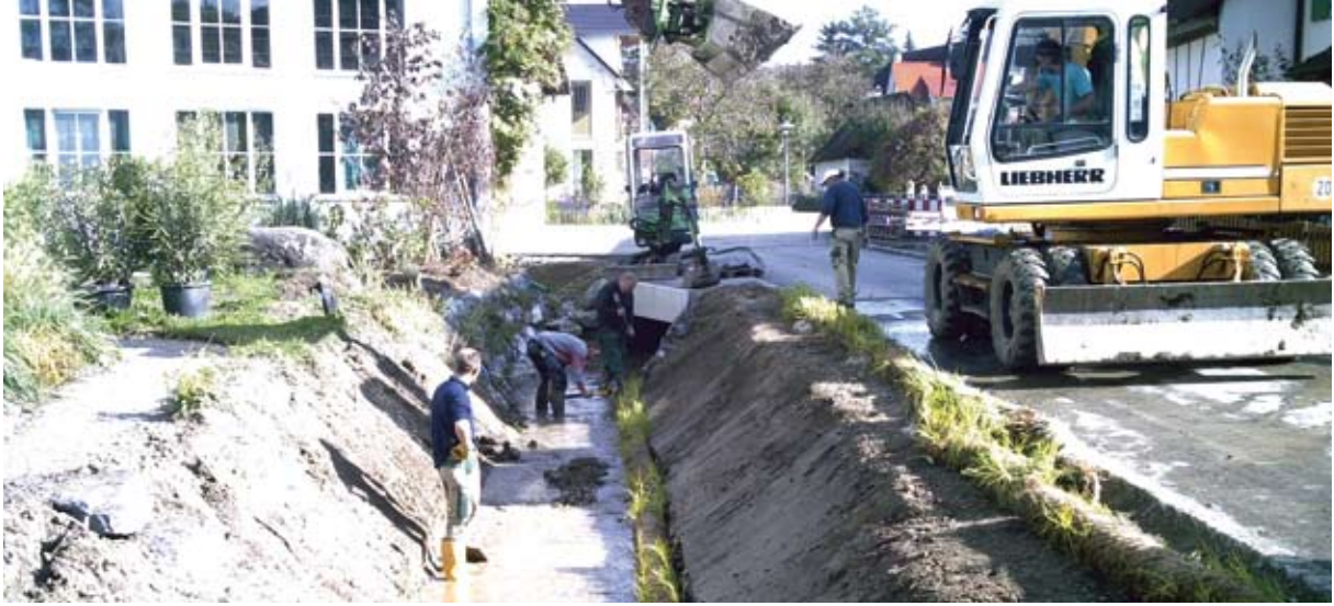
Einbau der Vegetationswalzen am Böschungsfuß
