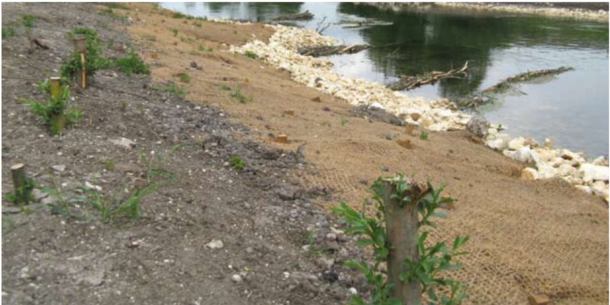
Austrieb der Setzstangen nach 8 Wochen
