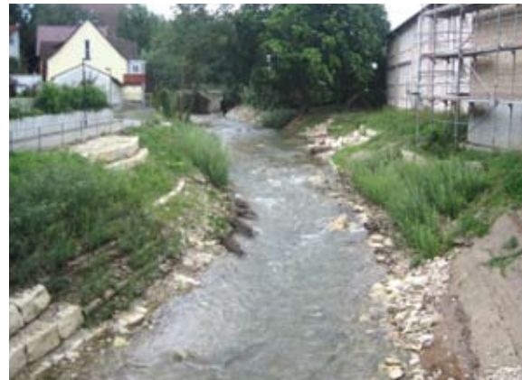
Baustelle nach Beendigung der Bauarbeiten
