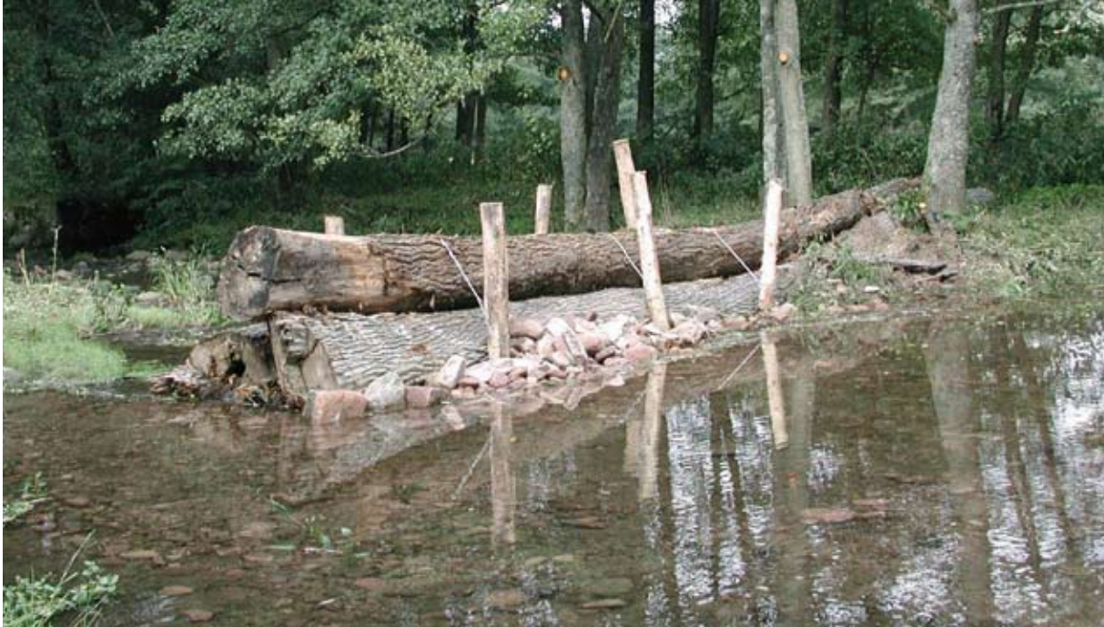
Pyramidenbuhne zwischen Uferbäumen, Sicherung mit 2x3 Pfählen und Draht (Gebler 2005)
