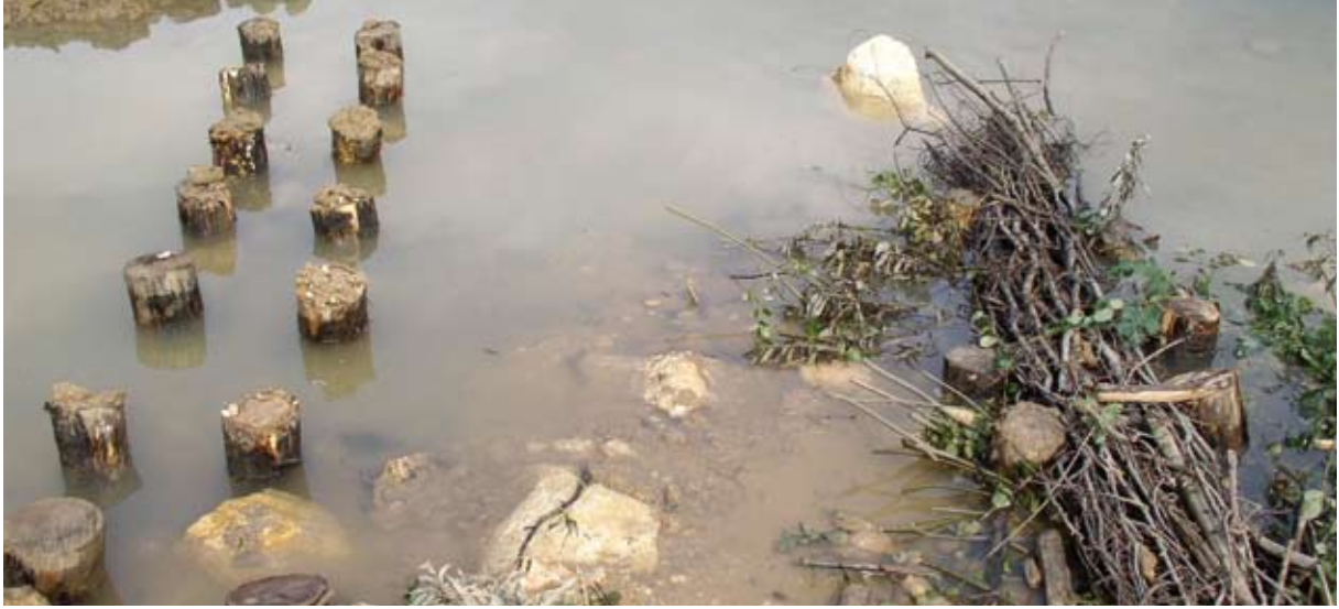
Bau der Lahnung (2007)
