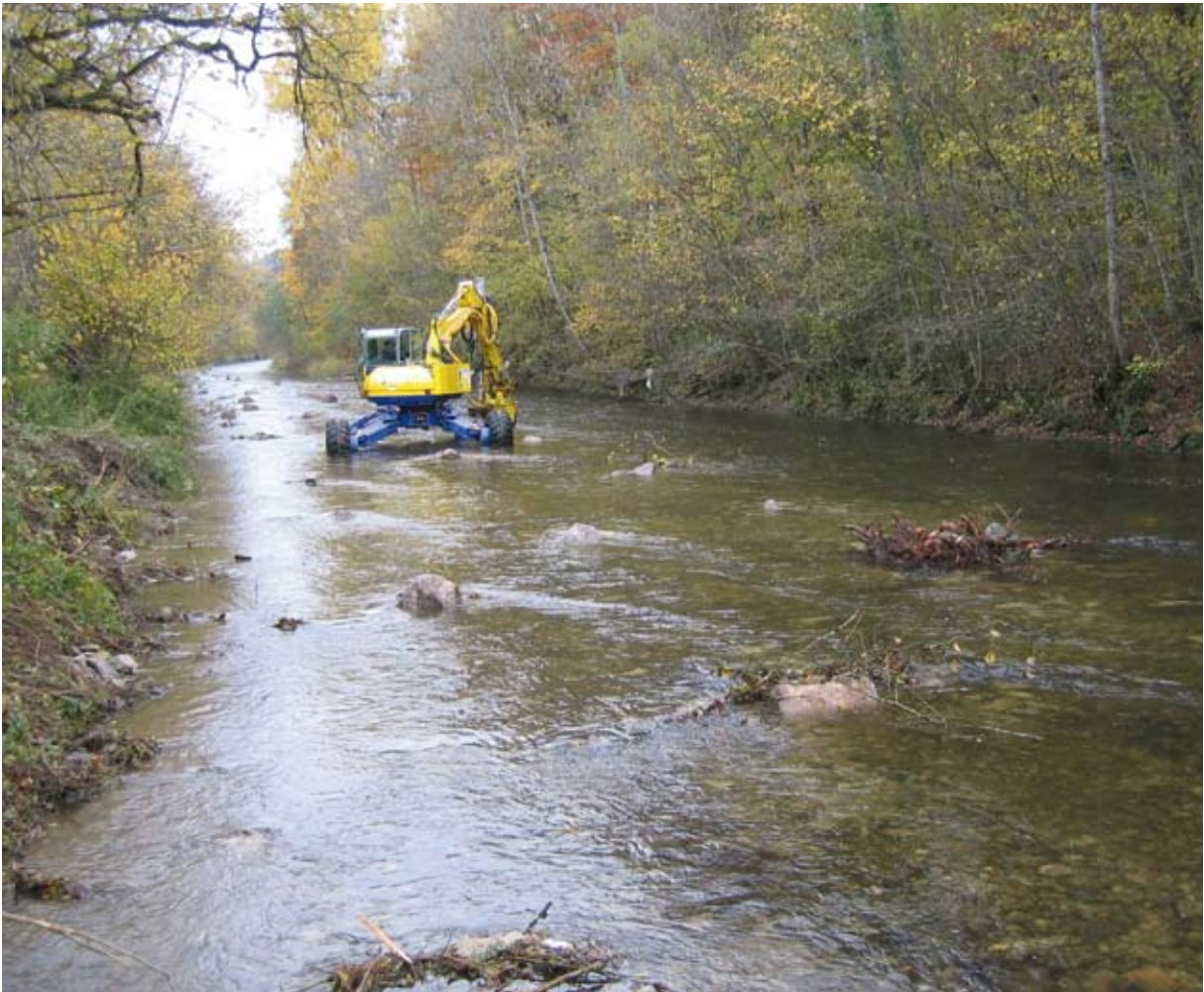
Einbau der Strukturelemente
