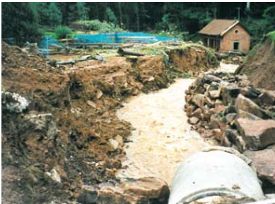
Hochwasserschäden bachabwärts der Unteren Kapfenhardter Mühle
