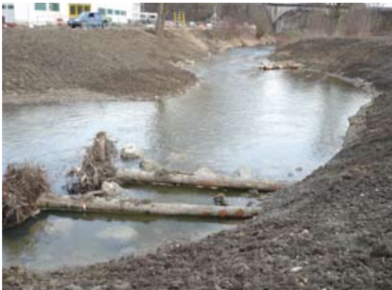
Fertig gestellte Wurzelbaumbuhnen (2010)
