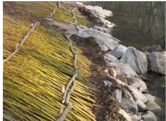
Detail der Spreitlage nach Fertigstellung
