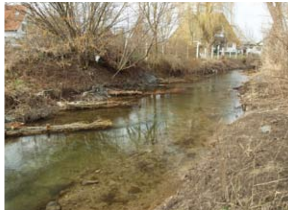
Nach Einbau der Strömungslenker und Vorlandabtrag
