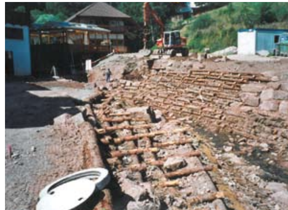
Herstellen von Krainerwänden
