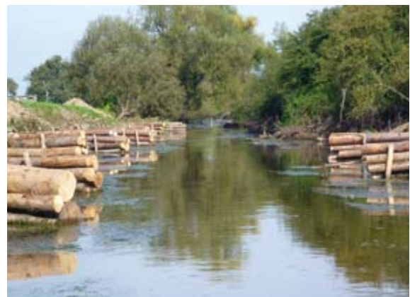
Eingebaute Ausfachungsbuhnen während des Bachabschlags
