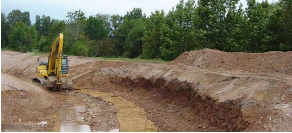
Vorbereitung für die unterste Lage der Geotextilfascine (2012)
