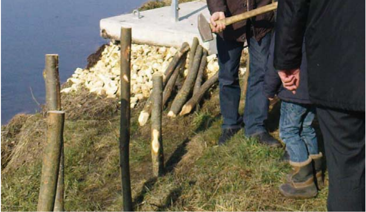
Einschlagen der Setzstangen mit dem Vorschlaghammer (2011)
