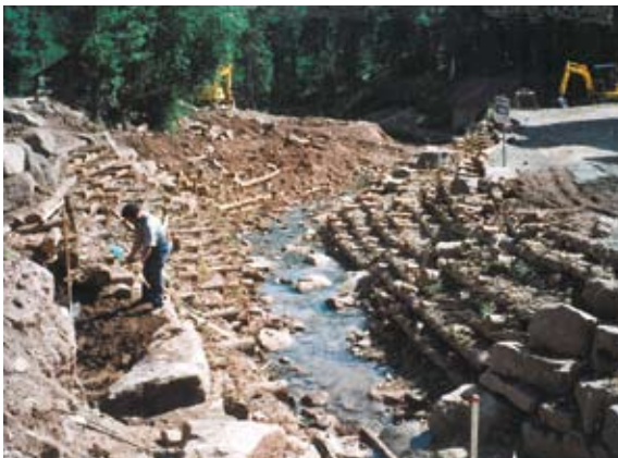
Bausausführung ingenieurbilogischer Bauweisen
